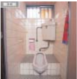
トイレリフォーム前
